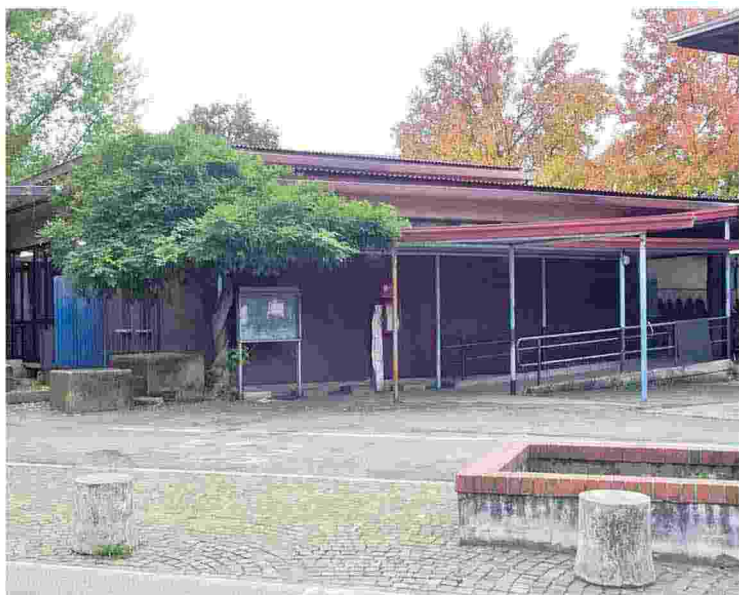
La scuola di Masseria diventerà autonoma dal punto di vista energetico
